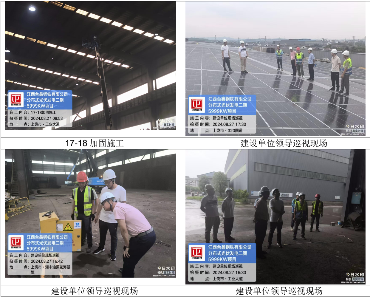
附一：施工过程及监督检查图片
