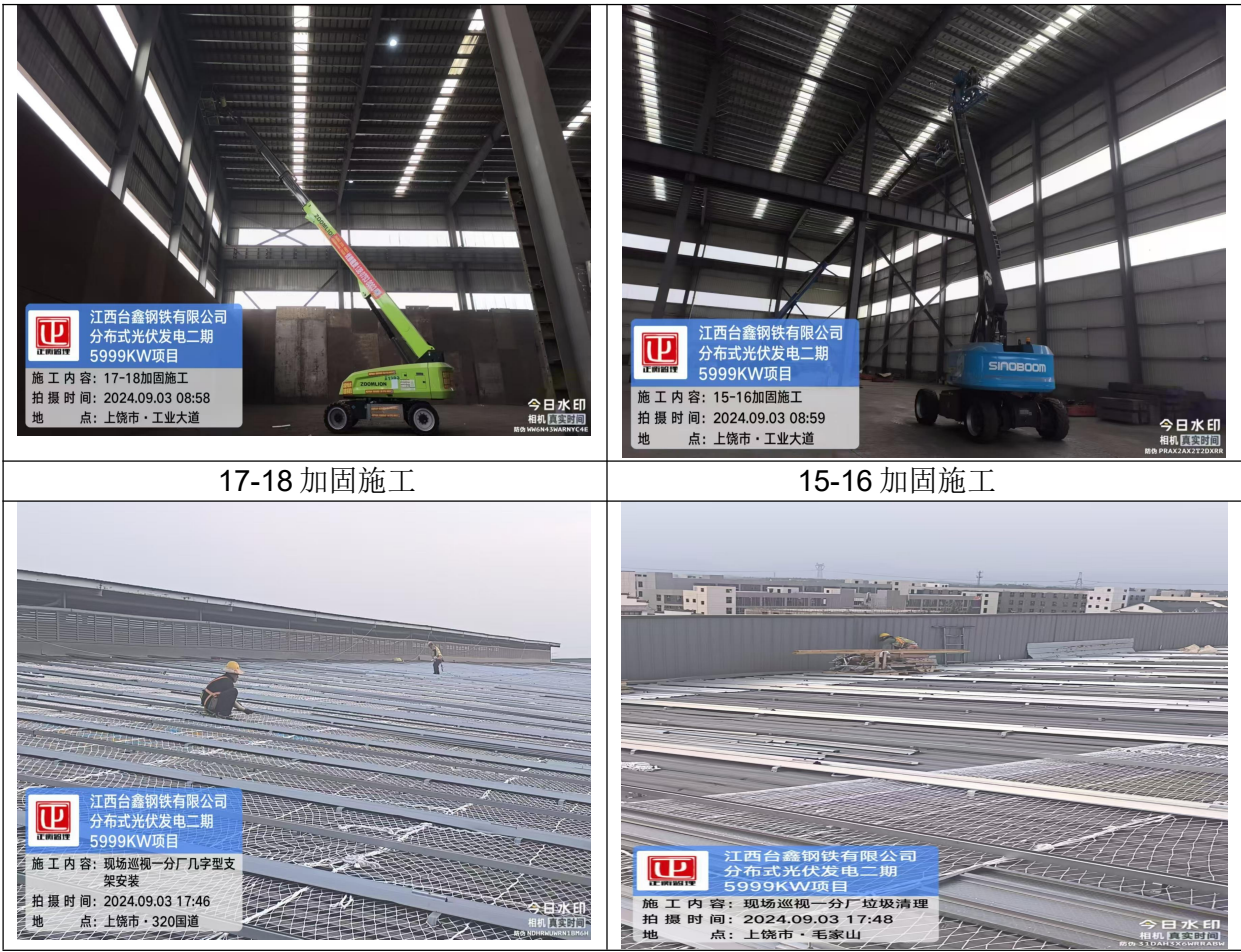
附一： 施工过程及监督检查图片
