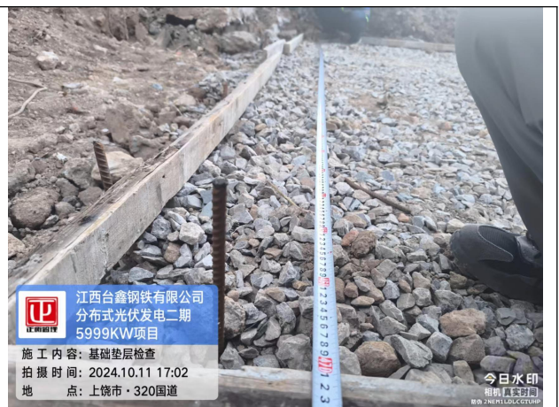
设备基础检查
