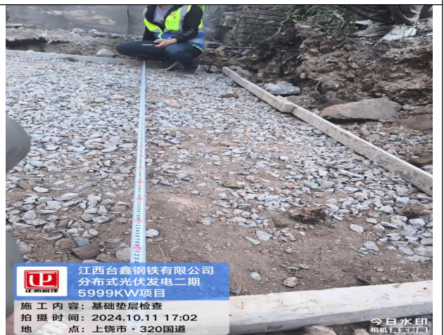
设备基础检查
