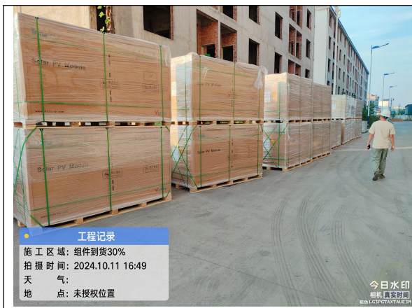
组件到场卸车
