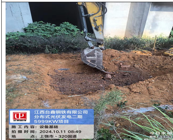
设备基础开挖
