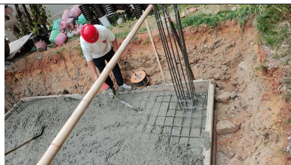
3#箱变基础底板浇筑
