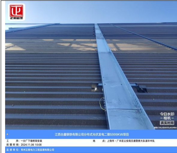
下墙桥架安装
