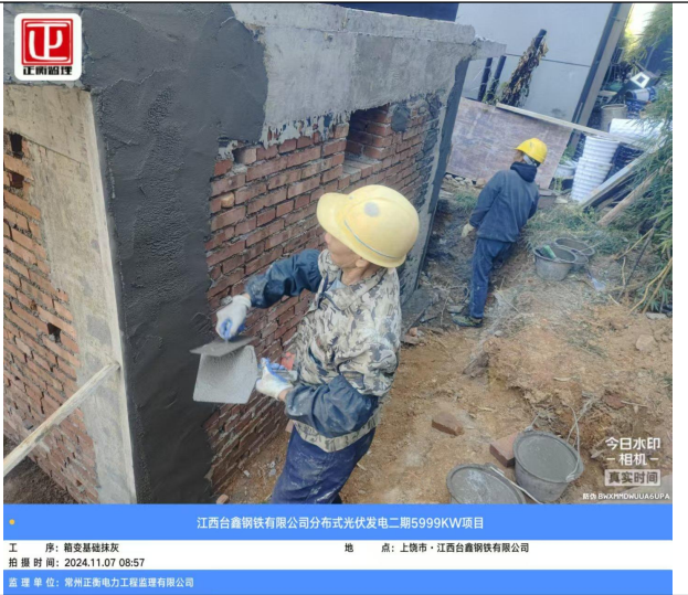
箱变基础抹灰
