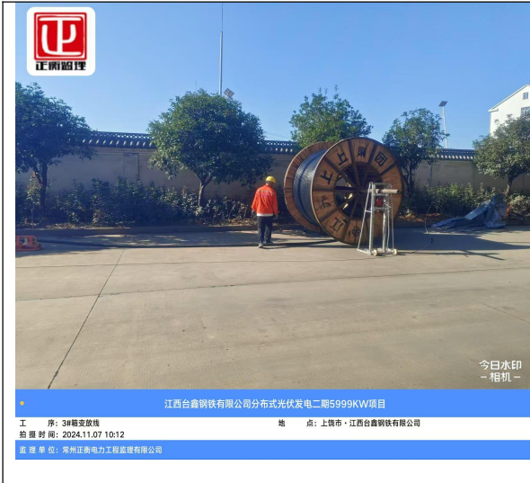
交流电缆放线
