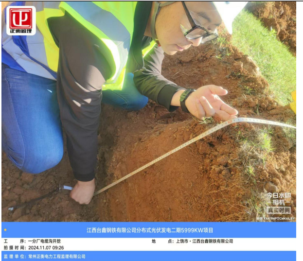
直埋电缆沟检查
