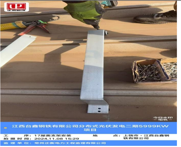
17 屋面支架安装
