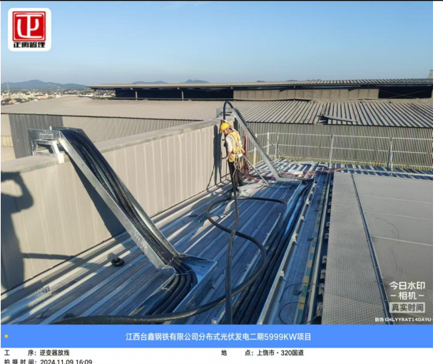
一分厂交流电缆放线
