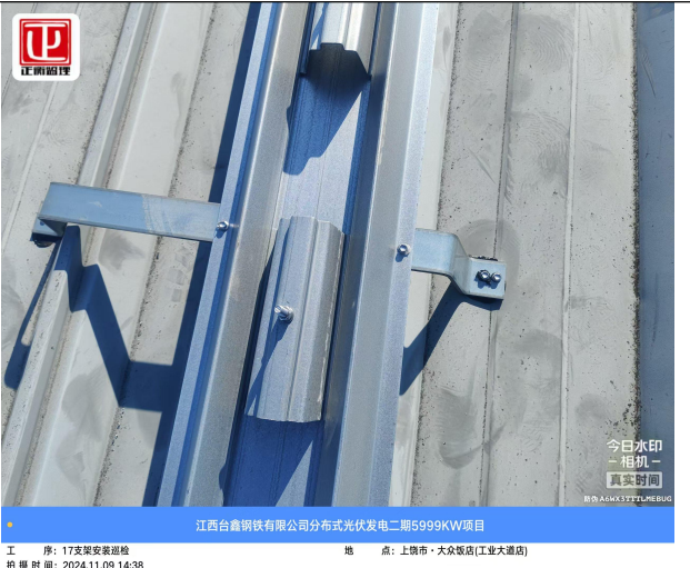
17 屋面支架安装
