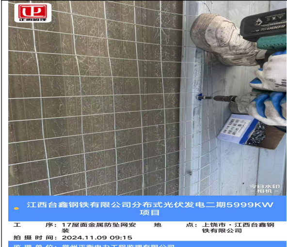
17 屋面防坠网安装
