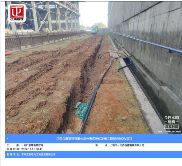
直埋电缆施工
