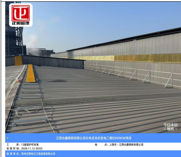
13屋面护栏安装
