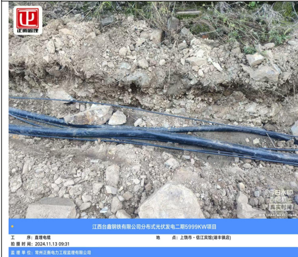
直埋电缆规格型号检查
