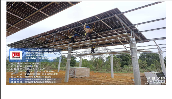
监理巡查三地块支架组件安装
