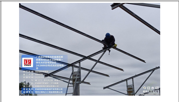
监理巡查三地块支架安装
