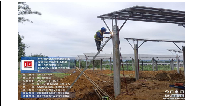
监理巡查三地块支架桩头焊接
