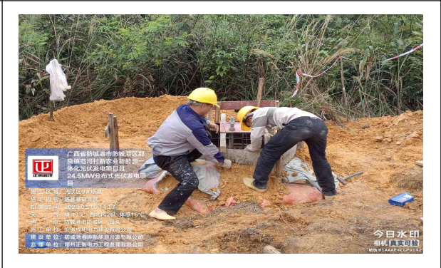
监理巡查 9#塔基基础混凝土浇筑
