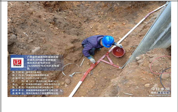
监理巡查三地块接地扁钢刷防锈漆
