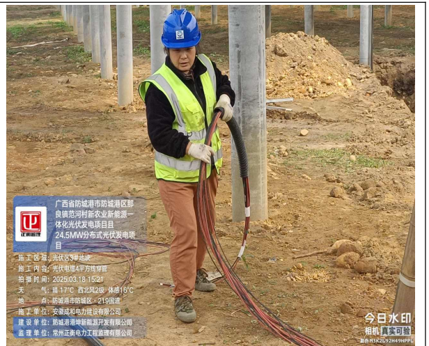
监理巡查三地块光伏4平方线穿管
