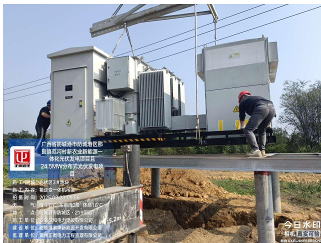
监理巡查三地块箱逆变一体机吊装
