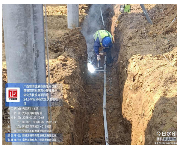
监理巡查三地块支架接地扁钢焊接
