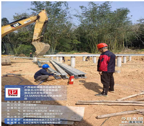
监理巡查一地块动火作业检查
