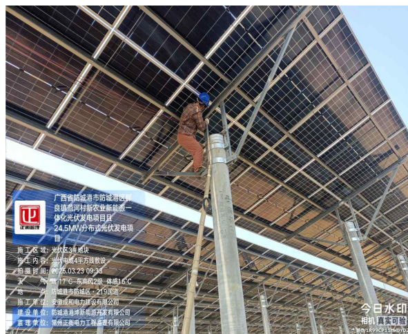
监理巡查三地块光伏4平方线敷设
