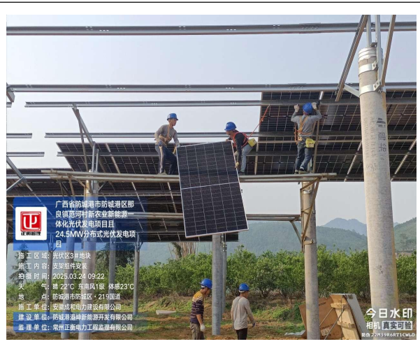
监理巡查三地块支架组件安装
