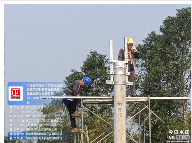
监理检查三号地块支架安装
