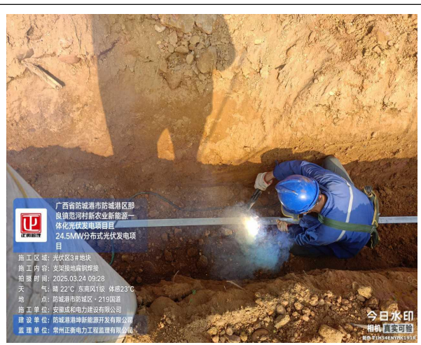
监理巡查三地块支架接地扁钢焊接
