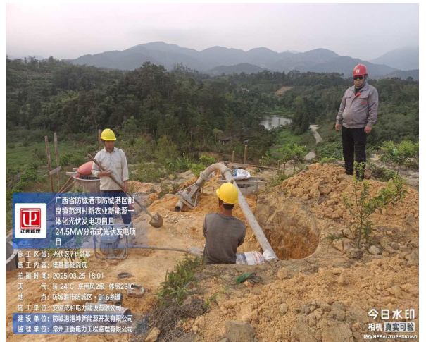
监理巡查 G7 塔基基础浇筑
