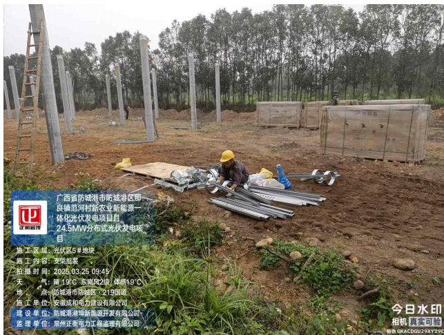
监理检查五号地块支架组装
