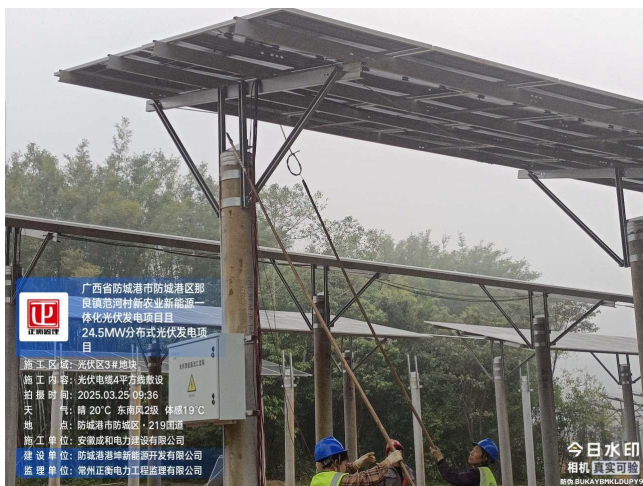
监理巡查三号地块 4 平放线敷设
