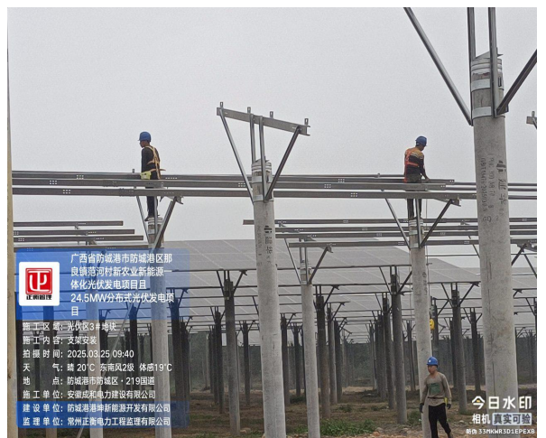
监理巡查三地块支架安装
