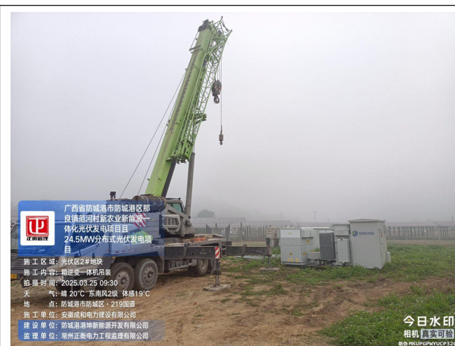
监理检查二号地块箱逆变一体机吊装
