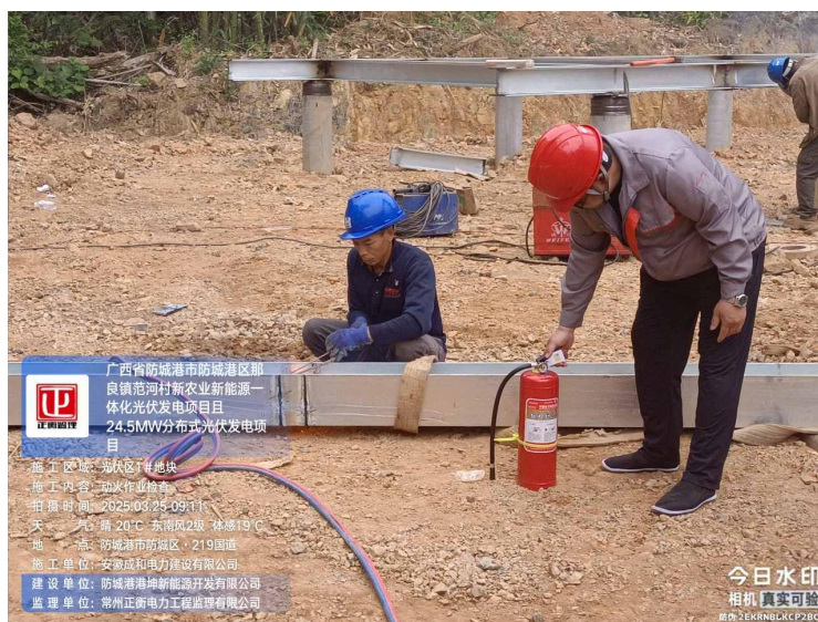
监理巡查一地块动火作业检查
