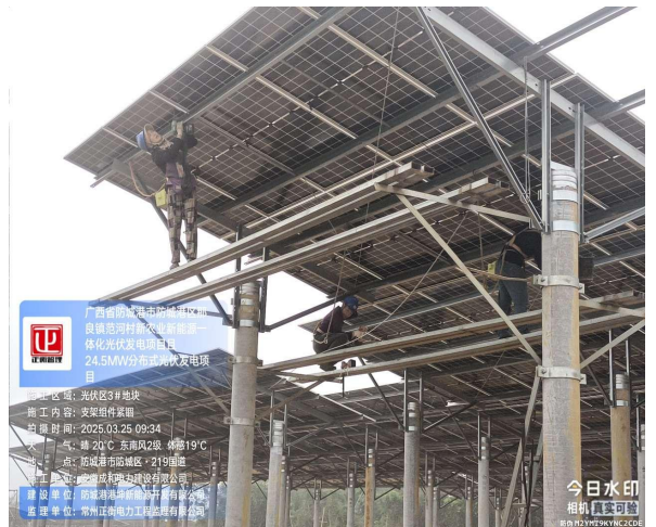
监理巡查三地块支架组件紧锢
