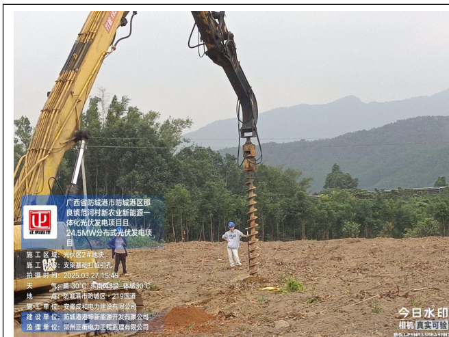
监理巡查二号地块支架基础打桩引孔
