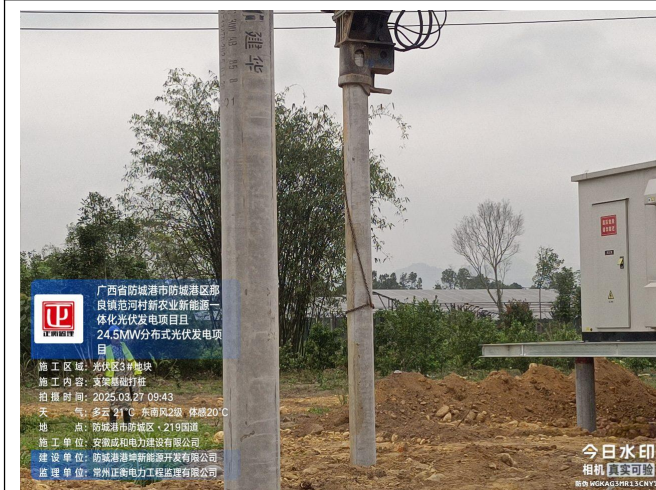
监理巡查三号地块支架基础打桩
