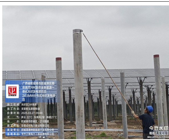
监理巡查三地块支架桩头刷银粉漆
