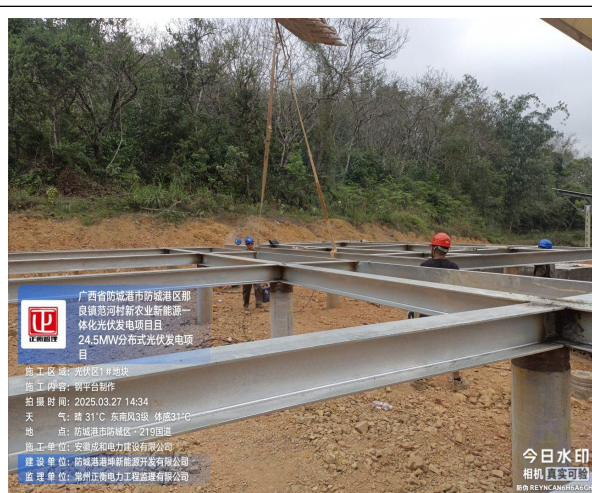
监理巡查一号地块钢平台制作
