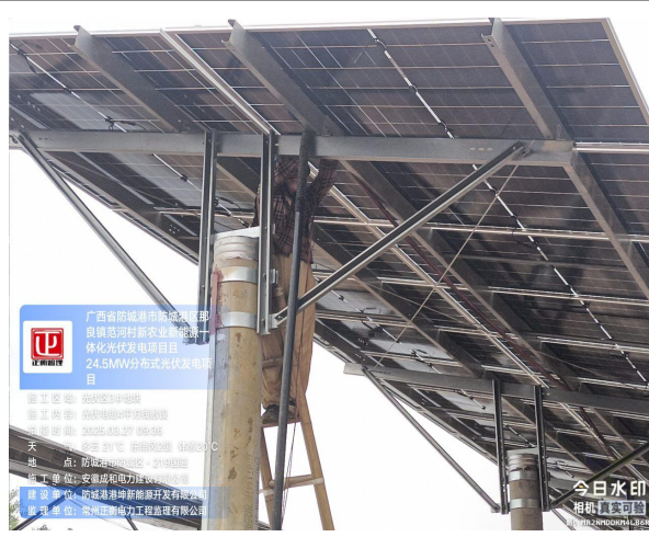
监理巡查三地块4平房电缆敷设
