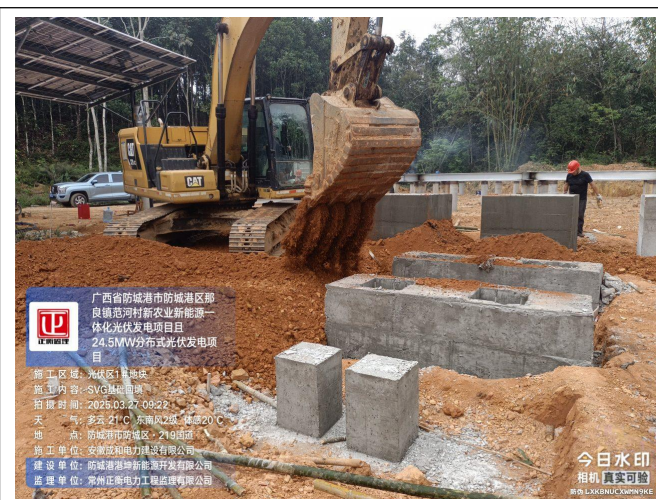
监理巡查一地块 SVG 基础回填
