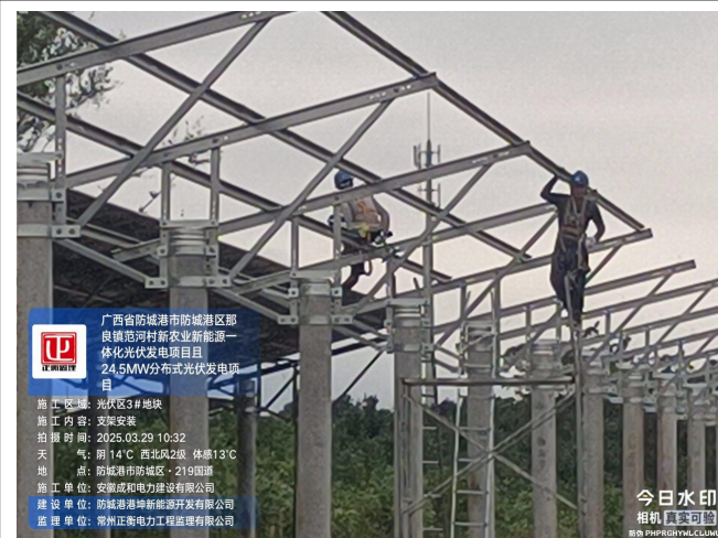
监理巡查三号地块支架安装
