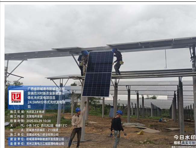
监理检查三号地块支架组件安装
