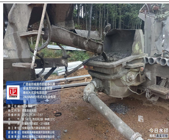
监理巡查 G2 塔基基础浇筑
