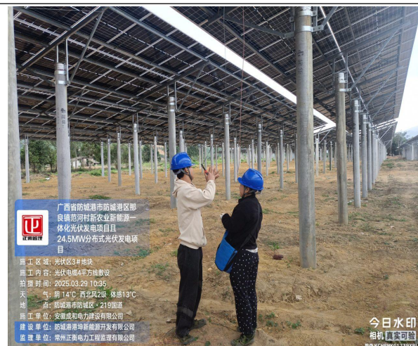
监理巡查三地块光伏 4 平房电缆敷设
