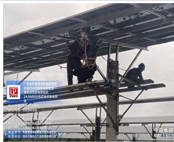
监理巡查三号地块支架组件安装
