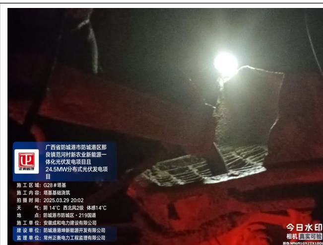
监理巡查 G28 塔基基础浇筑
