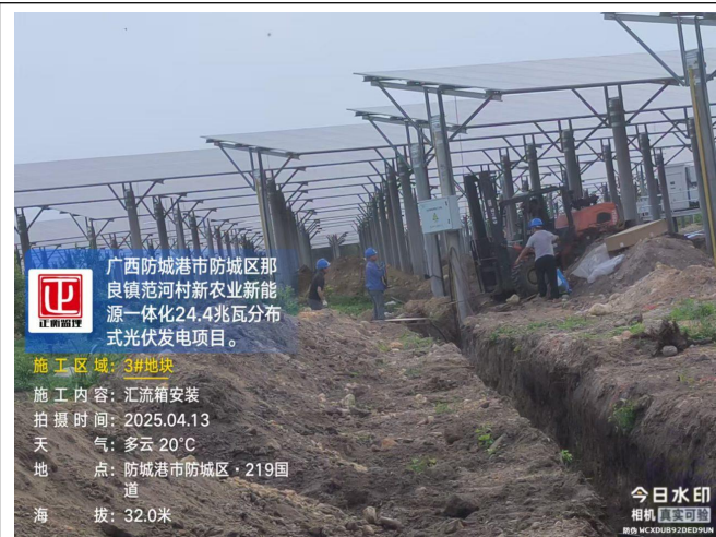
监理巡查光伏区三号地块汇流箱安装
