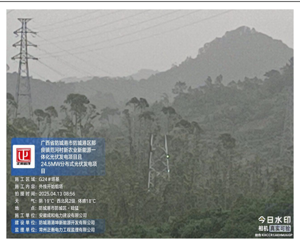
监理巡查外线 G24 塔基开始组塔
