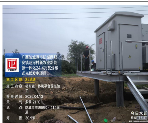
监理巡查光伏区三号地块箱逆变一体机平台围栏加工
