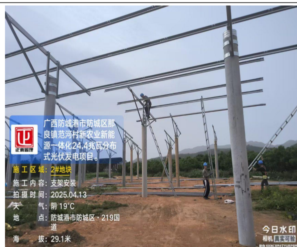
监理巡查光伏二号地块支架安装
