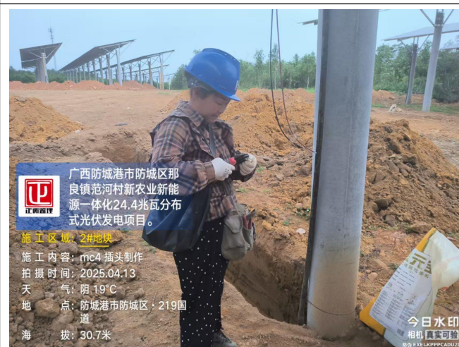
监理巡查光伏区二号地块 MC4 插头制作
