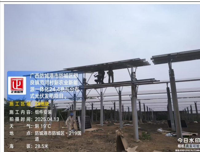
监理巡查光伏区二号地块组件安装
