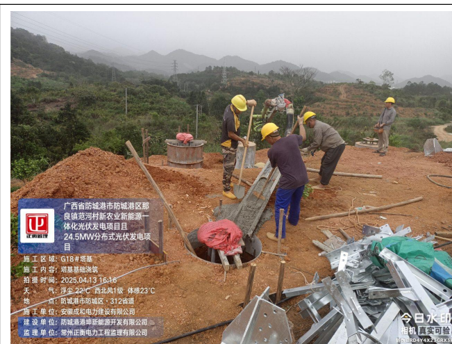
监理巡查外线 G18 塔基础浇筑
