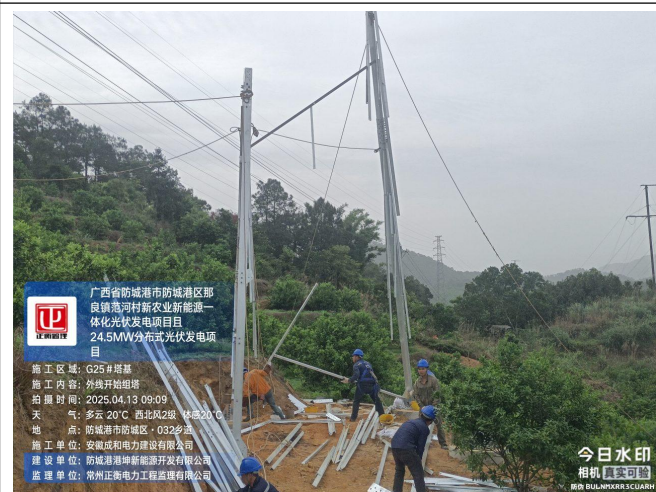
监理巡查外线 G25 塔基开始组塔
