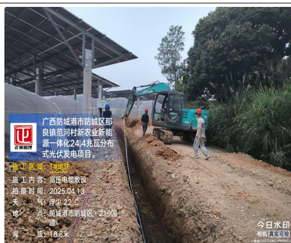
监理巡查光伏区一号地块高压电缆敷设
