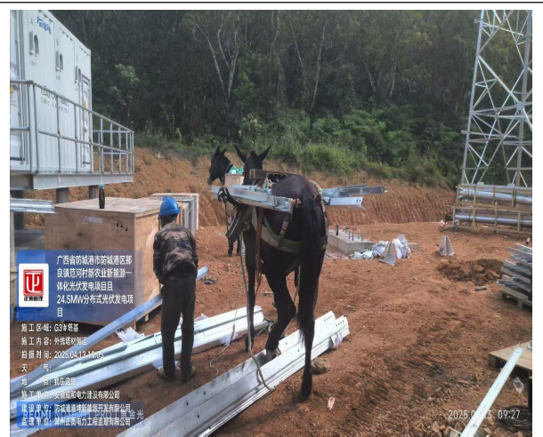
监理巡查外线 G3 塔基塔材倒运
