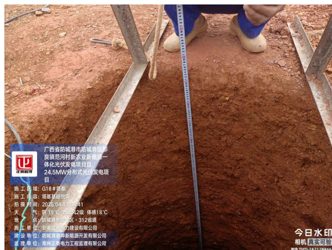
监理巡查外线 G18 塔基基础挖沟
