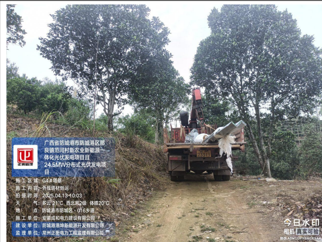
监理巡查外线 G4 塔基塔材倒运
