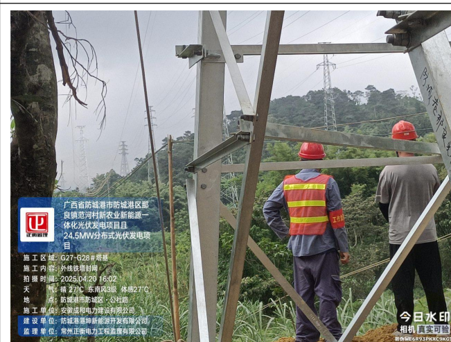
监理巡查外线 G27-G28 塔基封网
