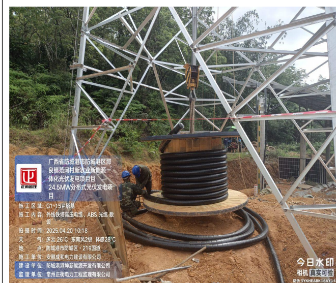
监理巡查外线 G1-G15 塔基高压电缆、ABS 光缆敷设
