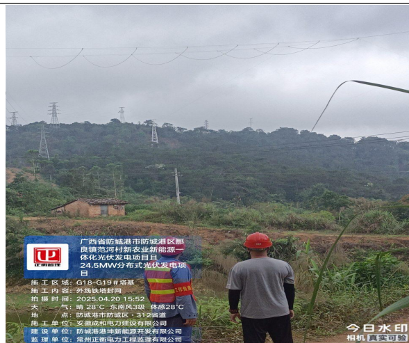
监理巡查外线 G18-G19 塔基封网
