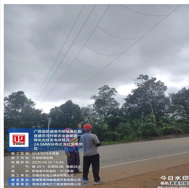
监理巡查外线 G14-G15 塔基封网
