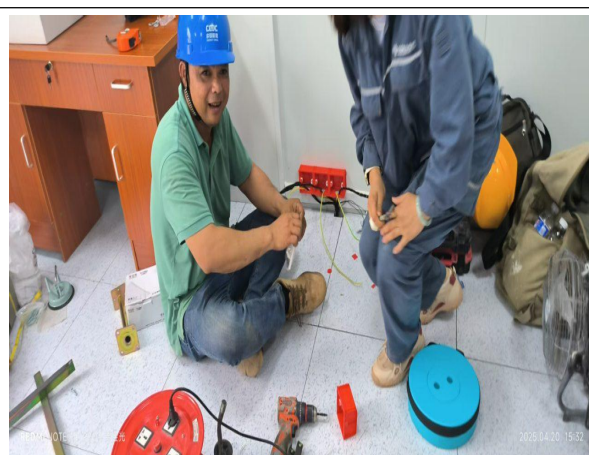
监理巡查光伏区升压站接线
