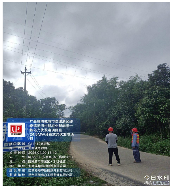
监理巡查外线 G11-G12 塔基封网
