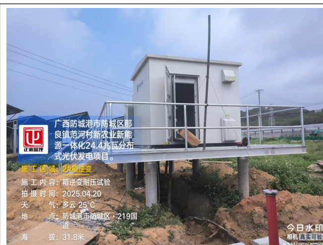
监理巡查光伏区2号箱变耐压试验
