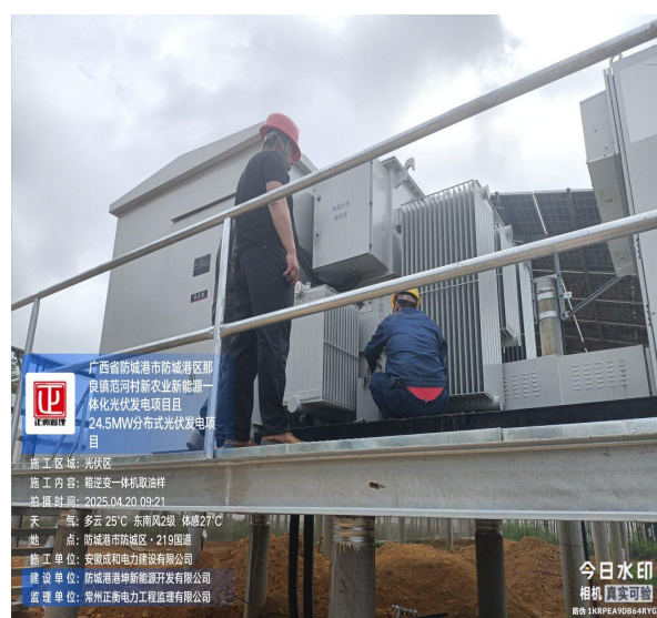
监理巡查光伏区箱逆变一体机取油样
