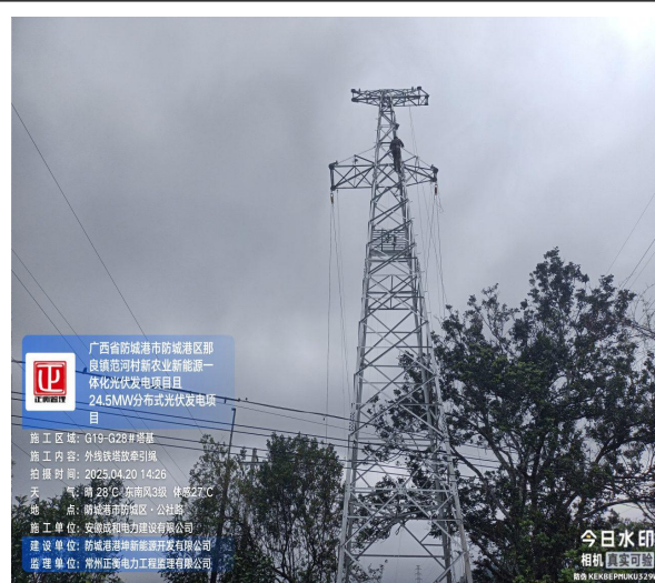
监理巡查外线 G19-G28 塔基放牵引绳
