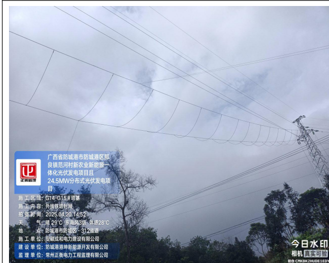
监理巡查外线 G14-G15 塔基封网
