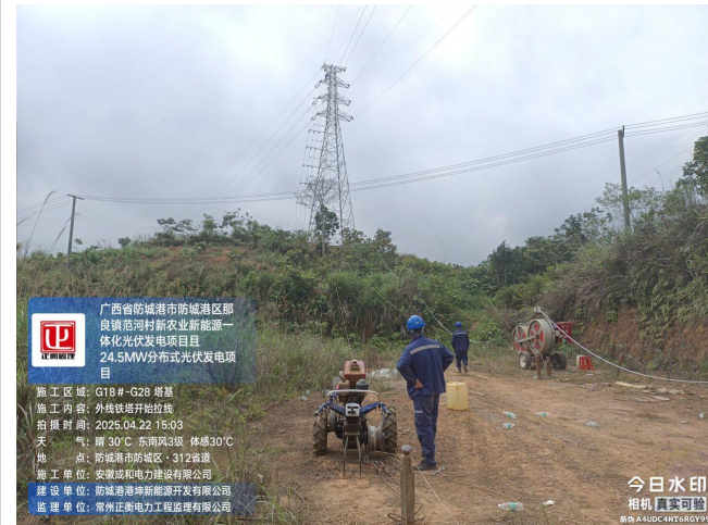
监理巡查外线 G18-G28 塔基开始拉线
