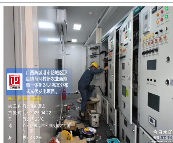
监理巡查光伏区升压保护调试
