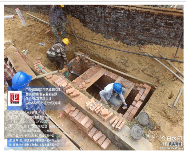
监理巡查外线 G28 塔基进站电缆井砌筑
