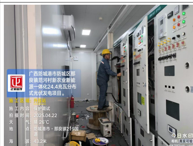
监理巡查光伏区升压保护调试
