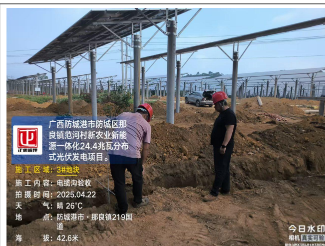
监理巡查光伏区三号地块电缆沟验收
