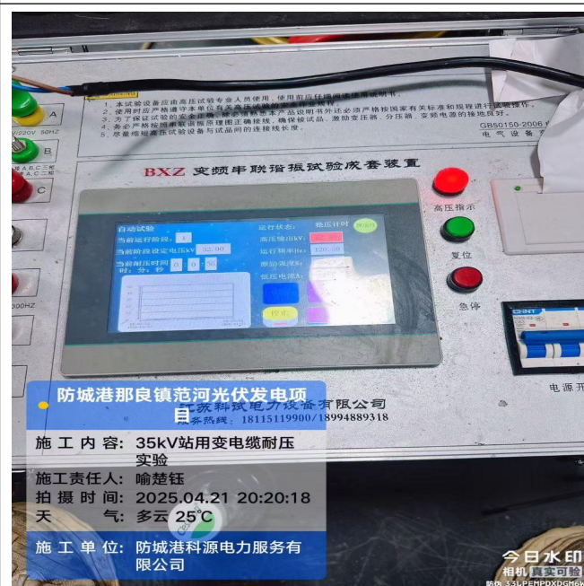
监理巡查光伏区升压站 35KV 用变电缆耐压试验
