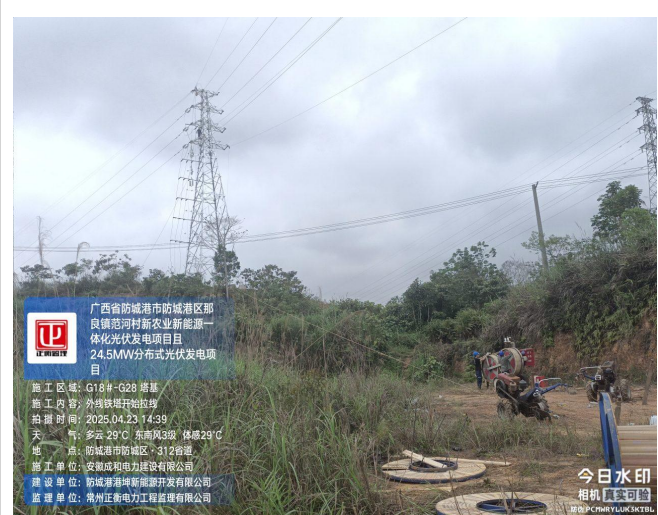
监理巡查外线 G18-G28 塔基开始拉线
