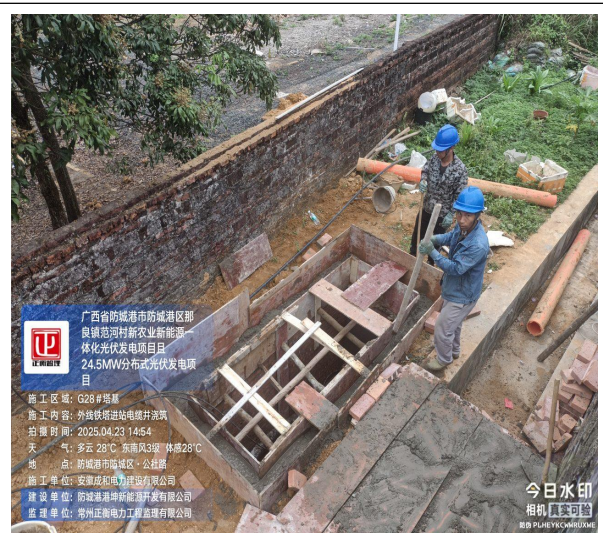
监理巡查外线 G28 塔基进站电缆井浇筑
