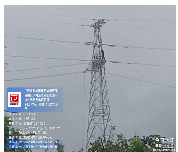
监理巡查外线 G12 塔基铁塔紧线
