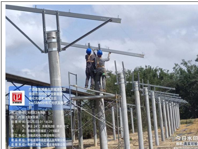
监理巡查三地块支架安装
