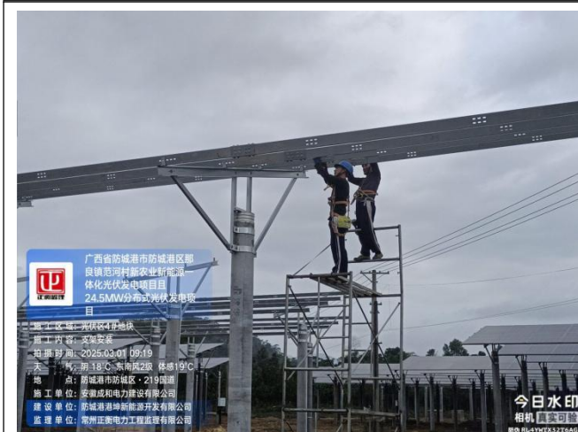
监理巡查四地块支架安装
