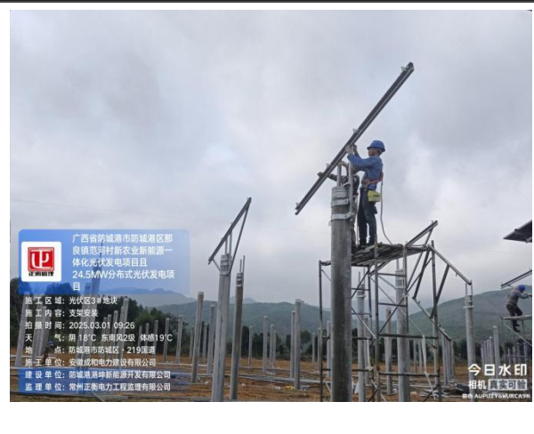
监理巡查三地块支架安装
