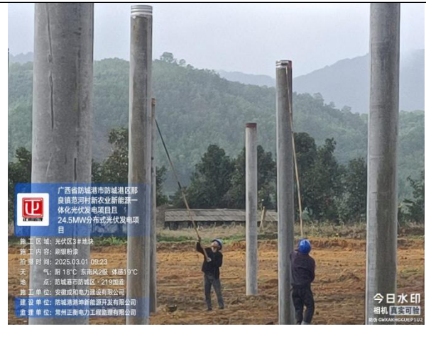
监理巡查三地块支架桩头刷银粉漆
