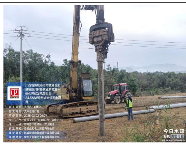
监理见证五地块支架基础打桩
