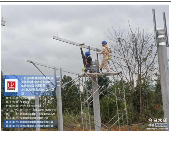
监理巡查三地块支架安装
