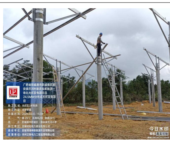
监理巡查三地块支架安装
