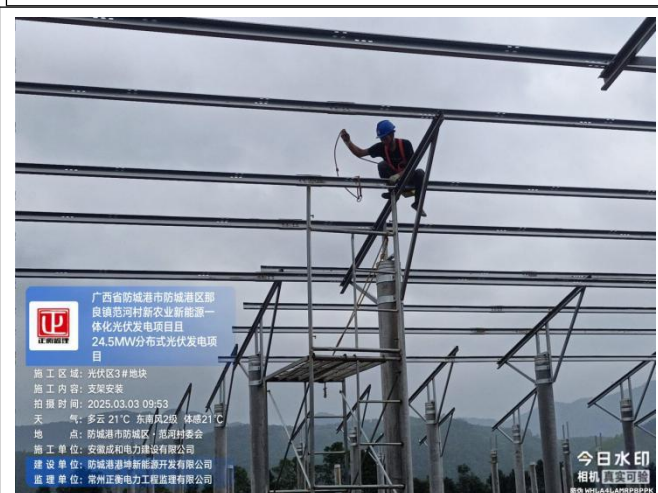
监理巡查三地块支架安装
