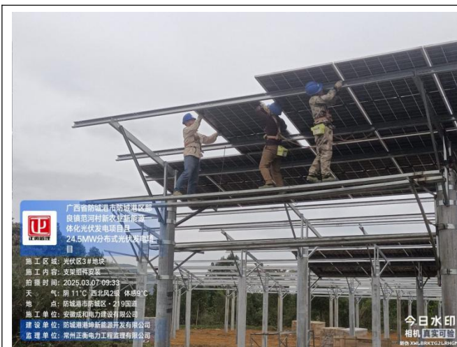
监理检查三号地块支架组件安装
