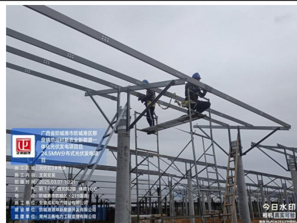
监理检查三号地块支架安装
