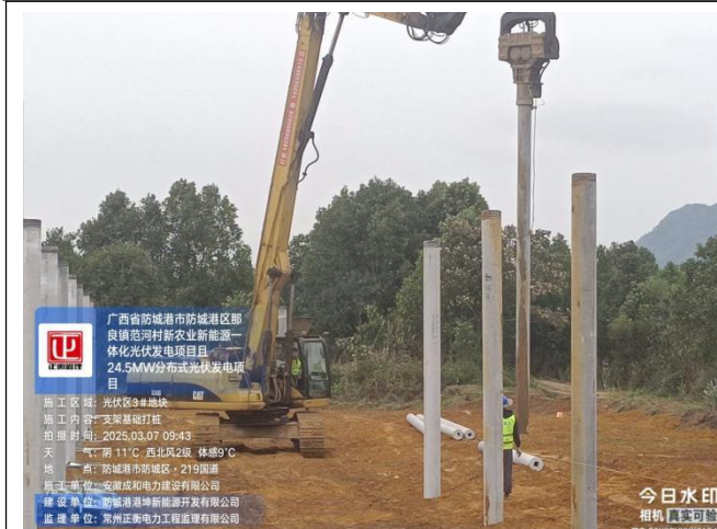
监理检查三号地块支架基础打桩
