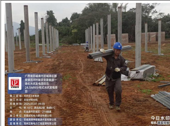
监理检查三号地块支架材料分料
