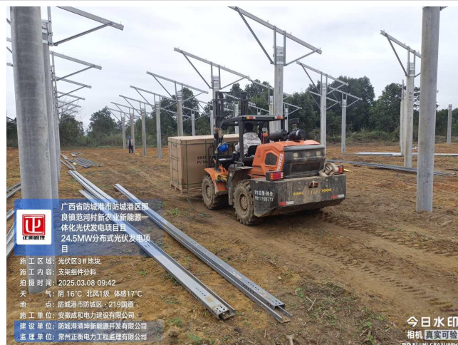
监理检查三号地块支架组件分料
