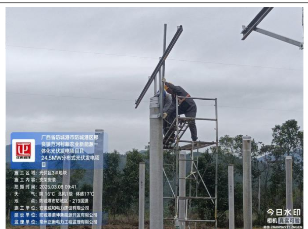
监理检查三号地块支架安装
