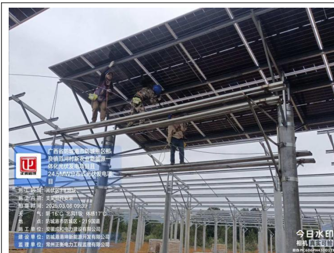
监理检查三号地块支架组件安装
