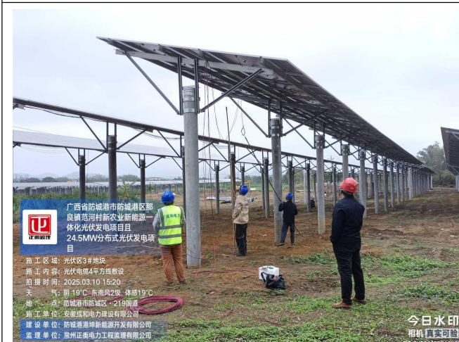
监理检查三号地块4平方线直流电缆敷设
