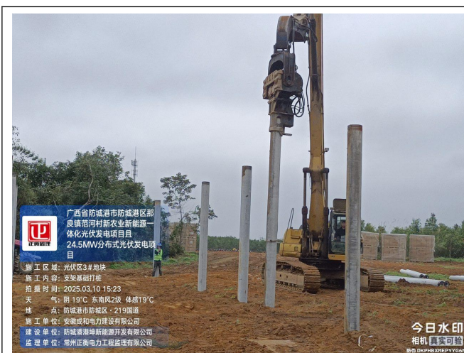
监理检查三号地块支架基础打桩
