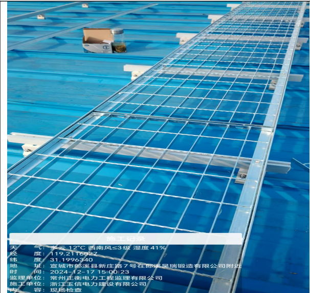
围栏固定方式与图纸不符
