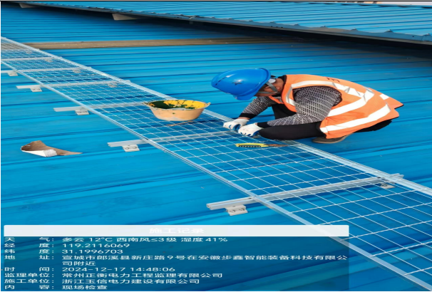
运维通道安装
