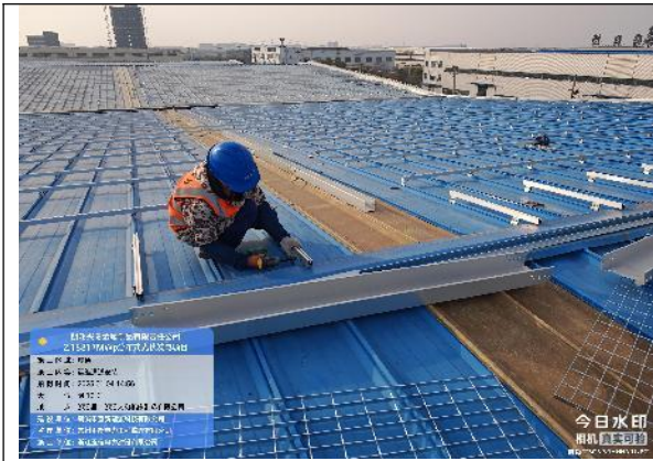
运维通道安装
