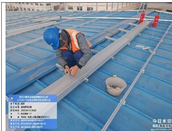
直流桥架安装
