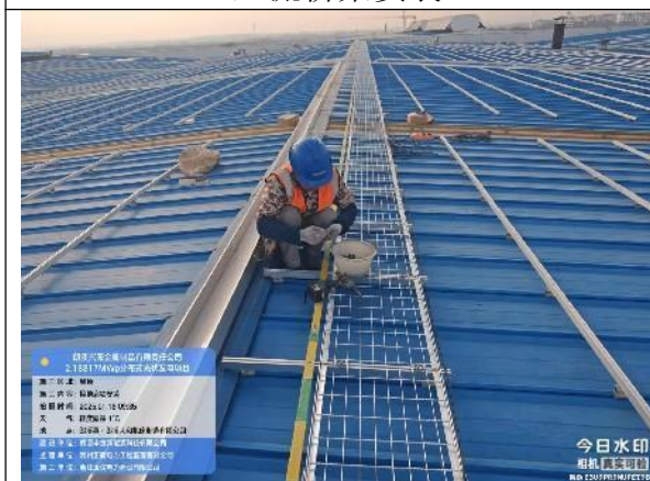
接地扁铁安装
