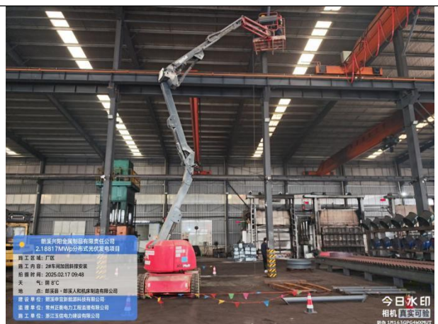
2#车间加固斜撑安装
