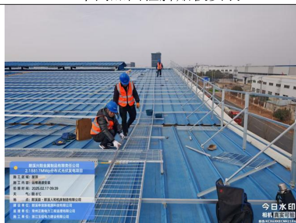
运维通道安装
