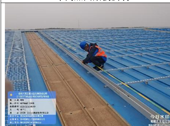
直流桥架打孔穿管
