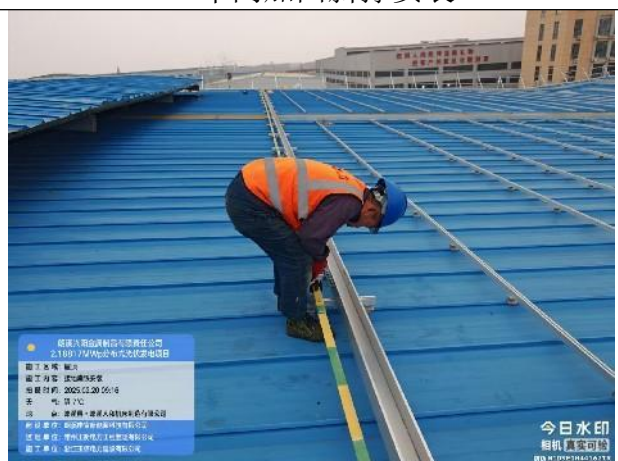
接地扁铁安装
