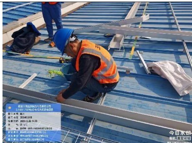
直流桥架安裝
