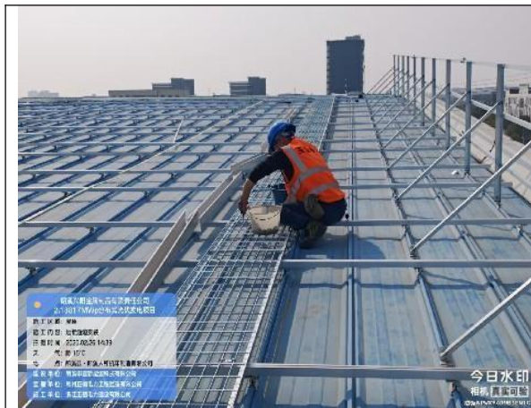
运维通道安装
