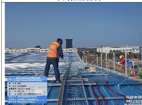
直流电缆敷设
