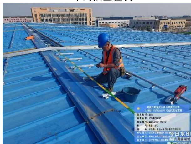
接地扁铁安装
