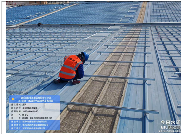
采光带防坠网安装
