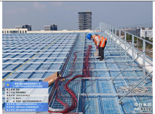
直流电缆敷设
