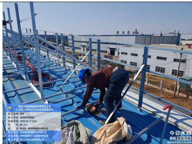
逆变器支架安装
