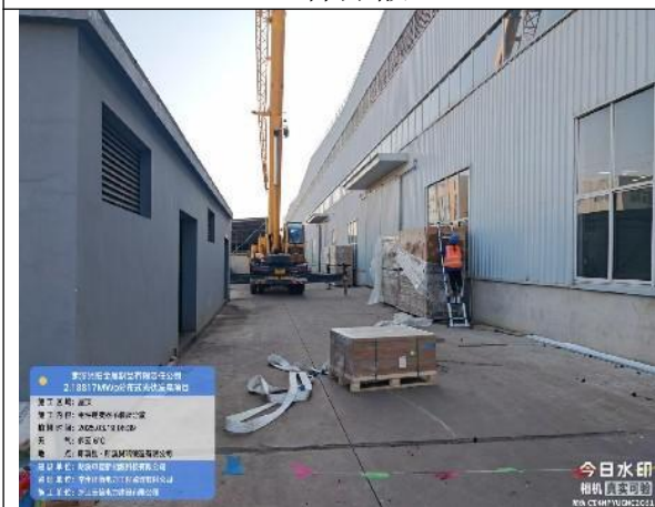
组件逆变器吊装及分散
