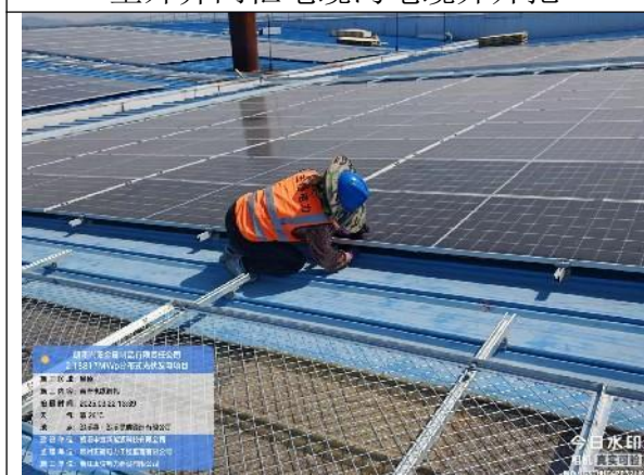
组件跨接线绑扎
