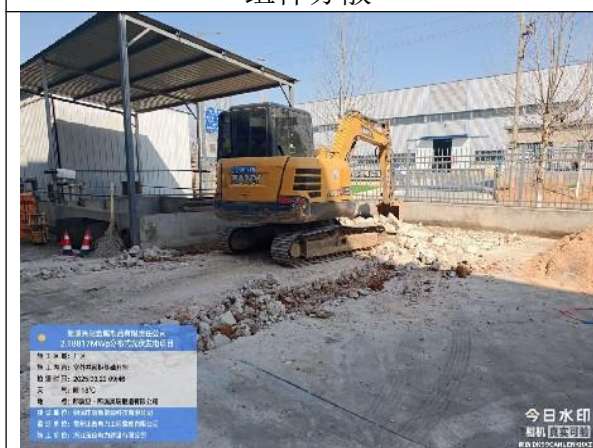
室外并网柜电缆沟电缆井开挖
