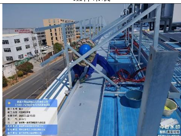
交流桥架安装
