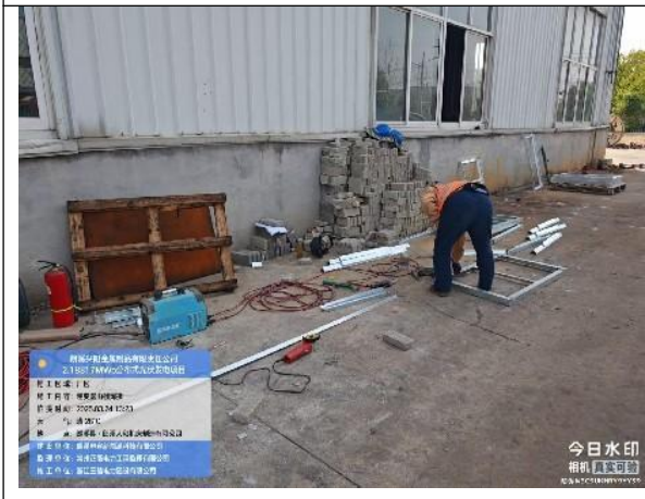
逆变器雨棚焊接
