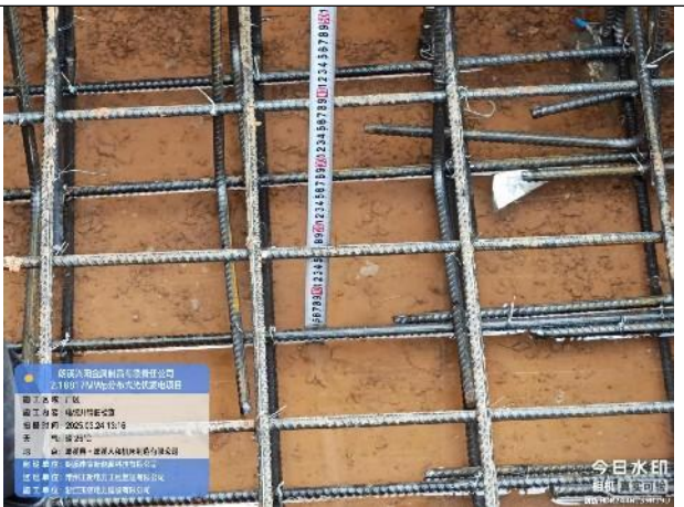
电缆井底板钢筋检查
