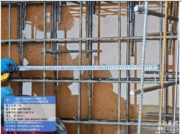
电缆井底板钢筋检查
