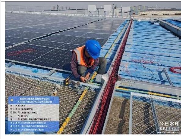
接地扁铁安装
