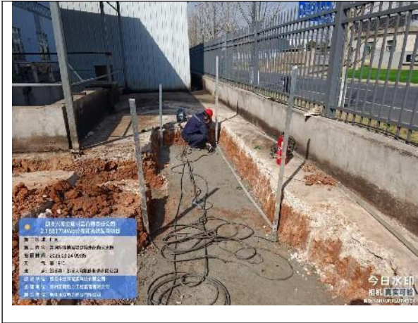
并网柜基础接地扁铁焊接
