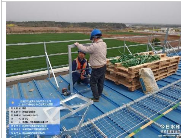
逆变器雨棚安装
