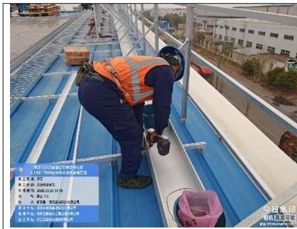
交流桥架安装
