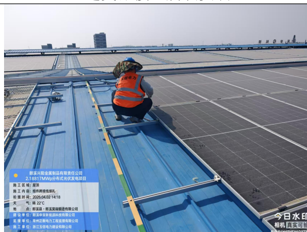
组件跨接线绑扎
