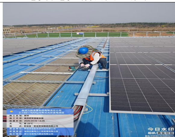
直流桥架盖板安装
