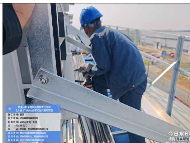
逆变器接地扁铁安装
