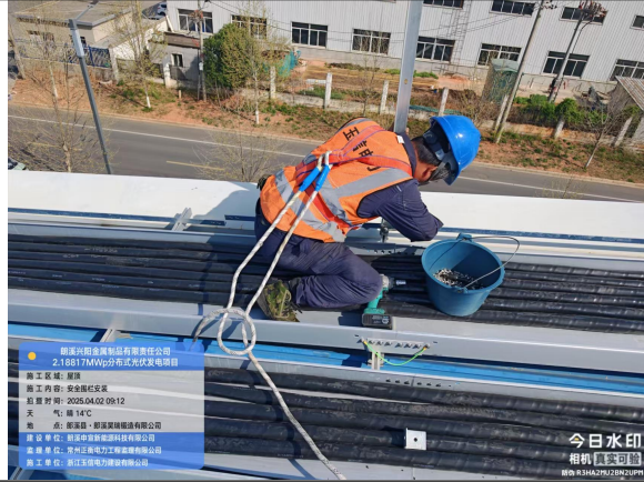
安全围栏安装
