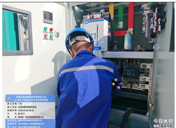
交流电缆终端制作安装
