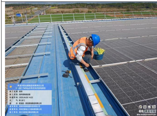
逆变器槽盒安装及 MC4 插头安装
