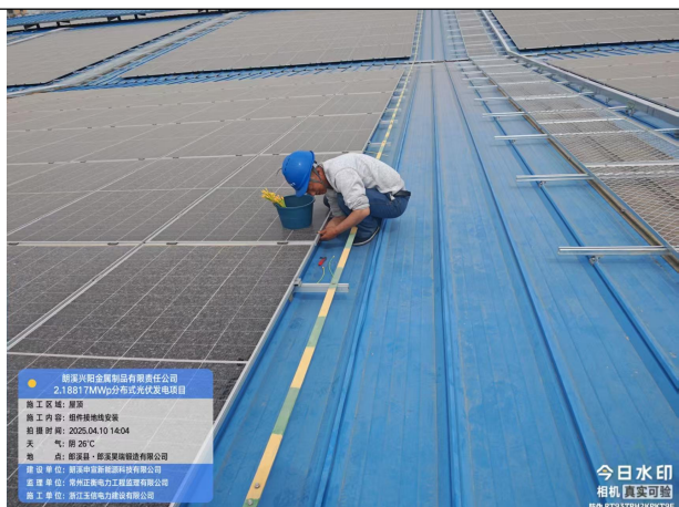
组件接地线安装
