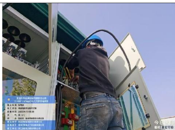
并网电缆终端制作安装
