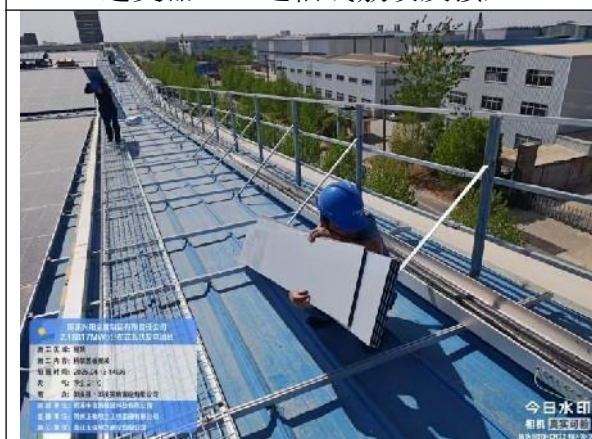
交流桥架盖板安装
