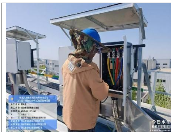
逆变器 485 通信线敷设及接入
