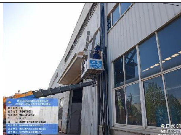
下墙交流桥架安装
