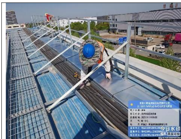
交流桥架盖板安装
