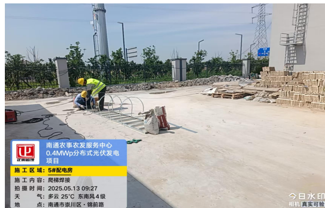
5#配电房爬梯制作
