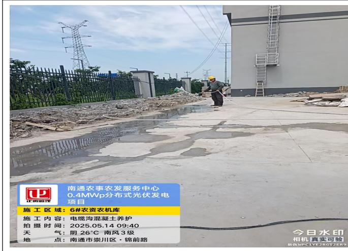
6#农资农机库电缆沟路面混凝土掩护
