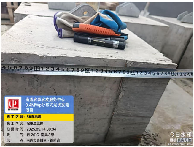
5#配电房配重块进场
