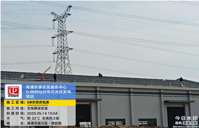
6#农资农机库支架横梁安装
