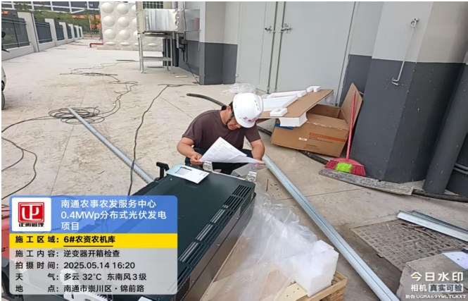
6#农资农机库逆变器开箱检查
