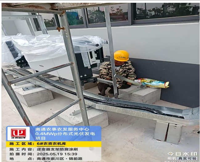
6#农资农机库逆变器支架防腐涂刷
