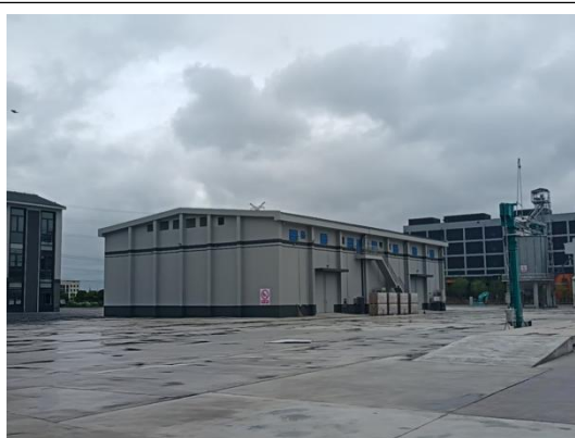
因雨未组织施工
