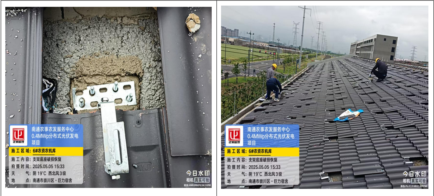
6#农资农机库支架底座、挂钩破坏原屋面结构部分的恢复工作
